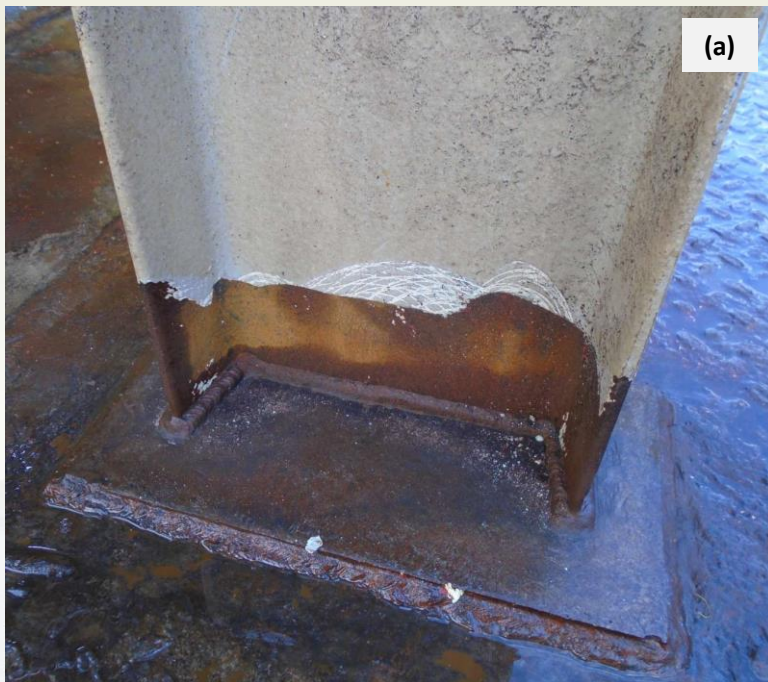
Fig. 5 - Ocorrência de flash rust em (a) base de estrutura e (b) volantes e acionadores de válvulas
