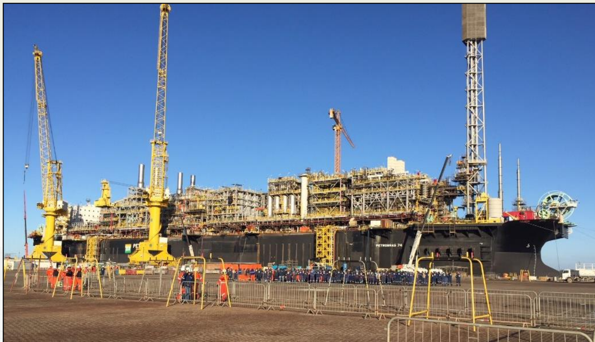
Fig. 27 - Implementação durante pintura de tanques de lastro em FPSO.
