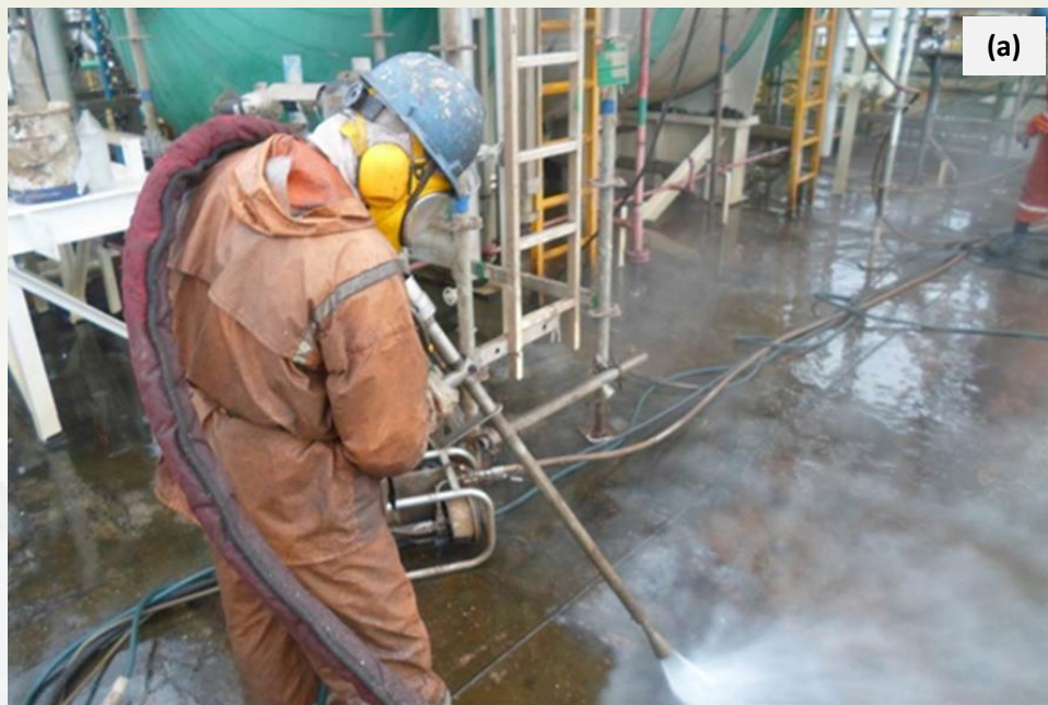
Fig. 1 - (a) Hidrojateamento UHP e (b) Jateamento abrasivo úmido ( realizando brush off )
