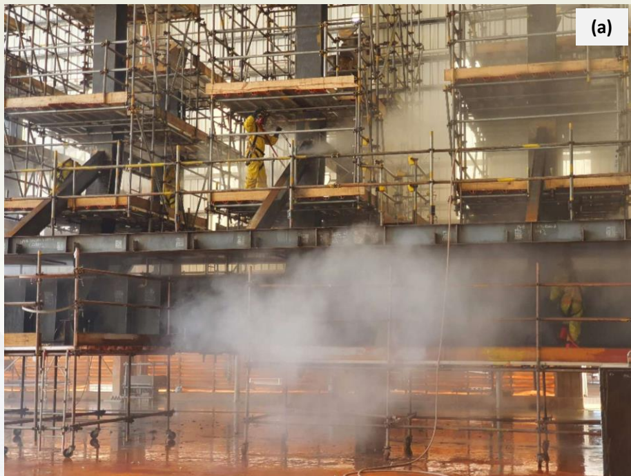
Fig. 2 - Hidrojateamento UAP (a) na construção e (b) na manutenção de unidades offshore
