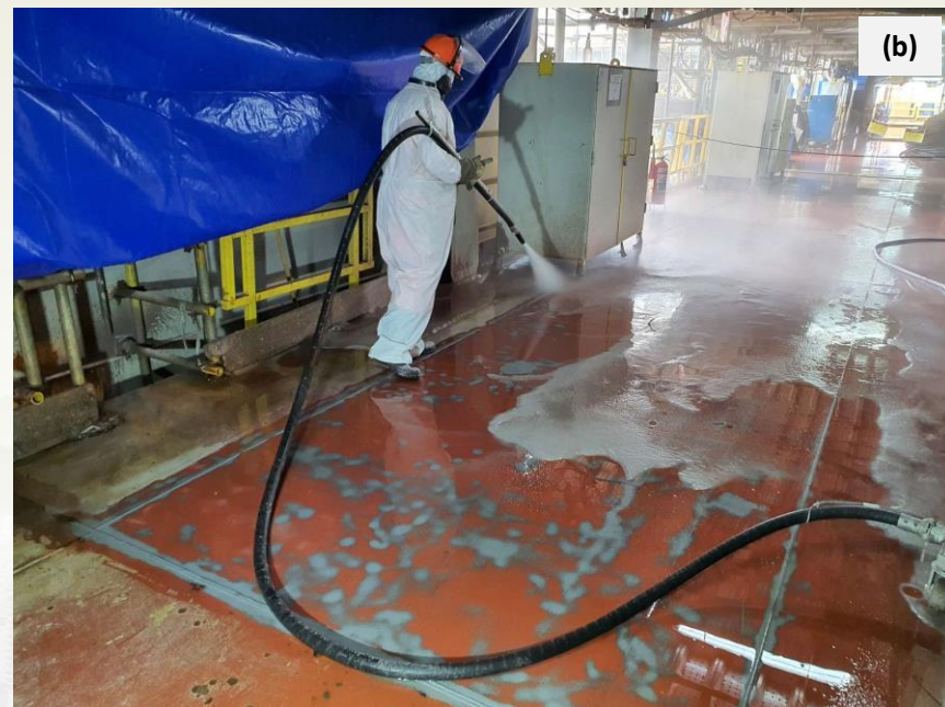
Fig. 1 - (a) Hidrojateamento UHP e (b) Jateamento abrasivo úmido ( realizando brush off )
