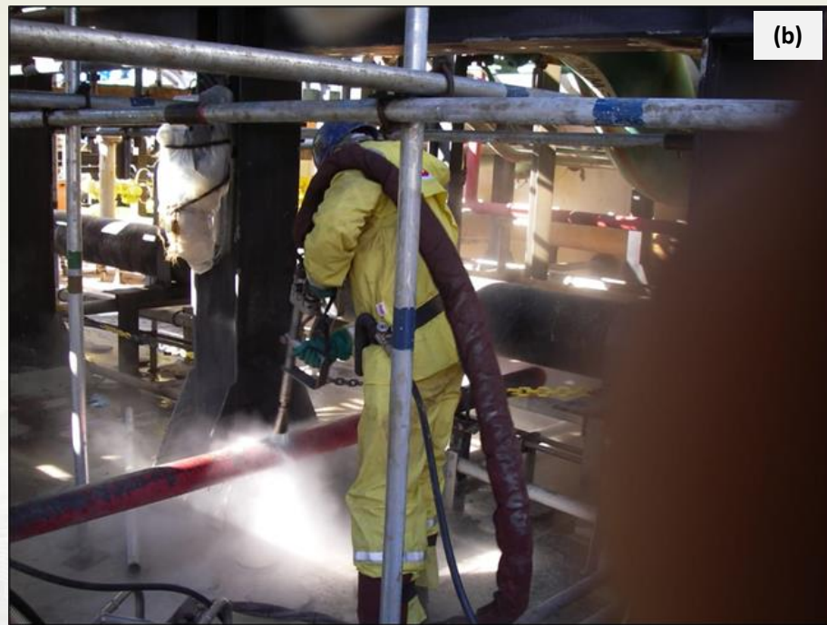
Fig. 2 - Hidrojateamento UAP (a) na construção e (b) na manutenção de unidades offshore
