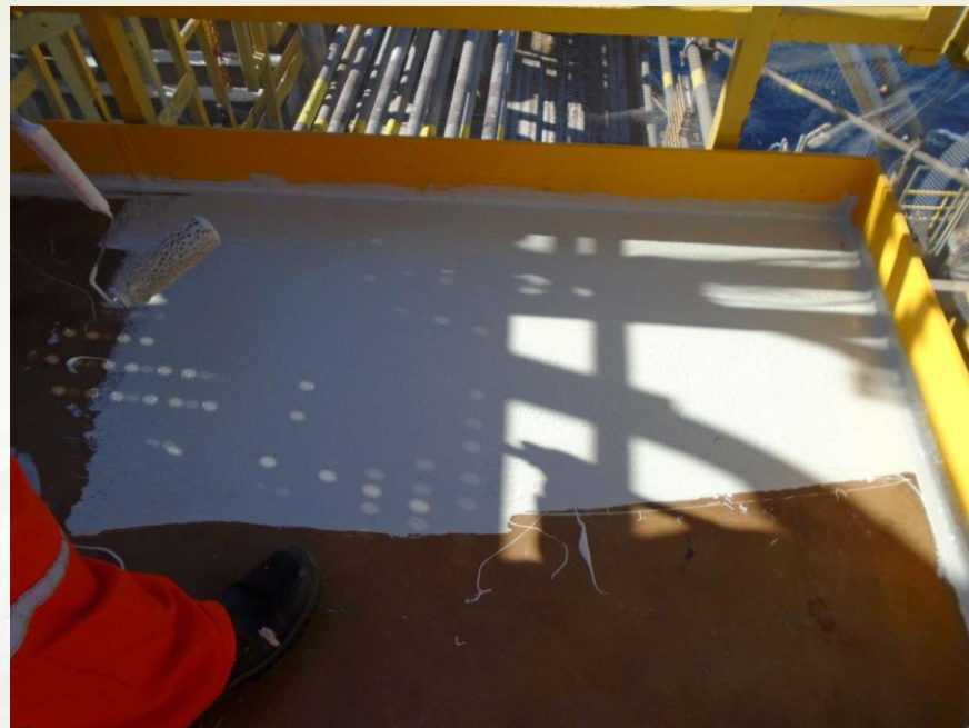
Fig. 6 - (a) Teste qualitativo de classificação do grau de flash rust e (b) pintura sobre flash rust
