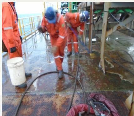
↑ Método de aplicação de Inibidor de flash rust : Vassoura!
