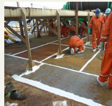
↑ Stripe Coat (Beleza!) Em cima de flash rust moderado (não tão beleza assim!)
