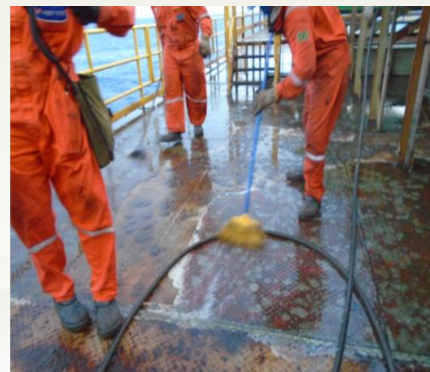
↑ Stripe Coat (Beleza!) Em cima de flash rust moderado (não tão beleza assim!)
